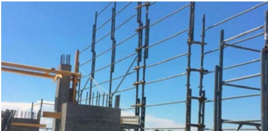
Un cantiere allestito con un ponteggio di PMG.
